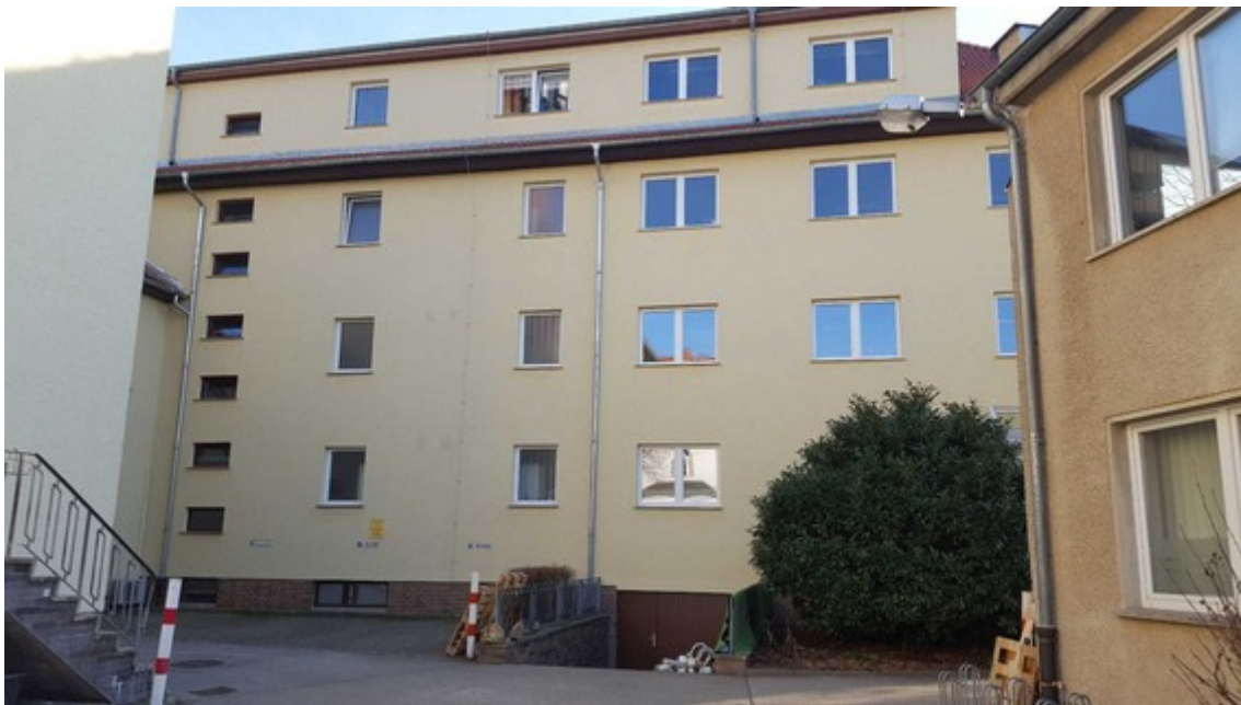
Bild 3. Ansicht von der Hofseite, mit befahrbarem Zugang zu den Werkstattbereichen, rechts das alte Konstruktionsgebäude
