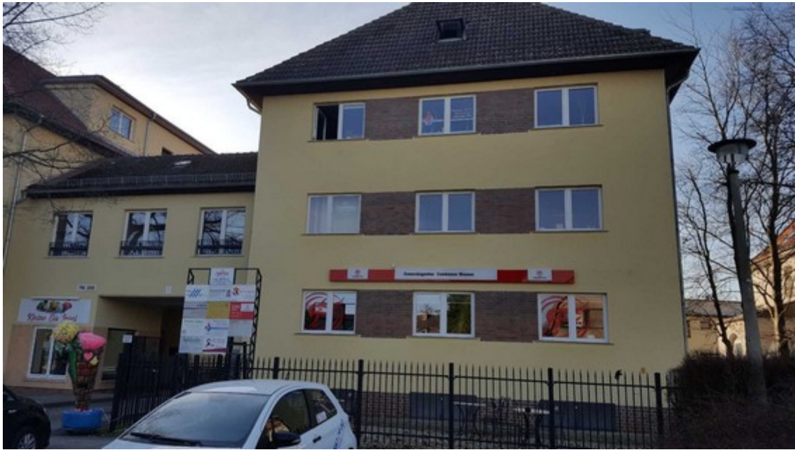
Bild 2: Neubau – Ansicht von der Straßenseite, ganz rechts unten im Erdgeschoß war mein Arbeitsplatz, links eine begehbare Brücke über die Hofeinfahrt zum Verwaltungsgebäude
